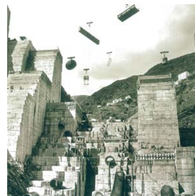
Salime. Detalle de la presa en construcción
