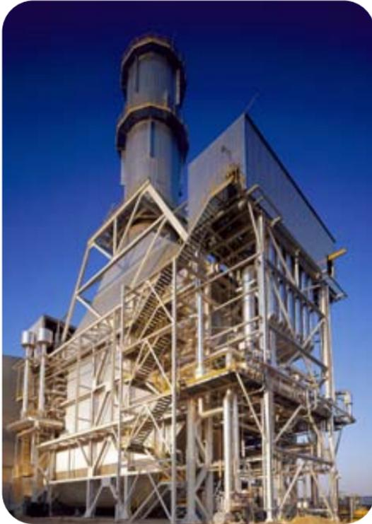
La instalación consta de dos grupos en funcionamiento, el primer grupo (Castejón 1) desde el año 2002 y el segundo (Castejón 3) desde comienzos de 2008. Cada uno de ellos se compone de una turbina de gas y una turbina de vapor dispuestas sobre un único eje, de modo que sólo disponen de un alternador para la generación de energía eléctrica instalado entre ambas turbinas.
