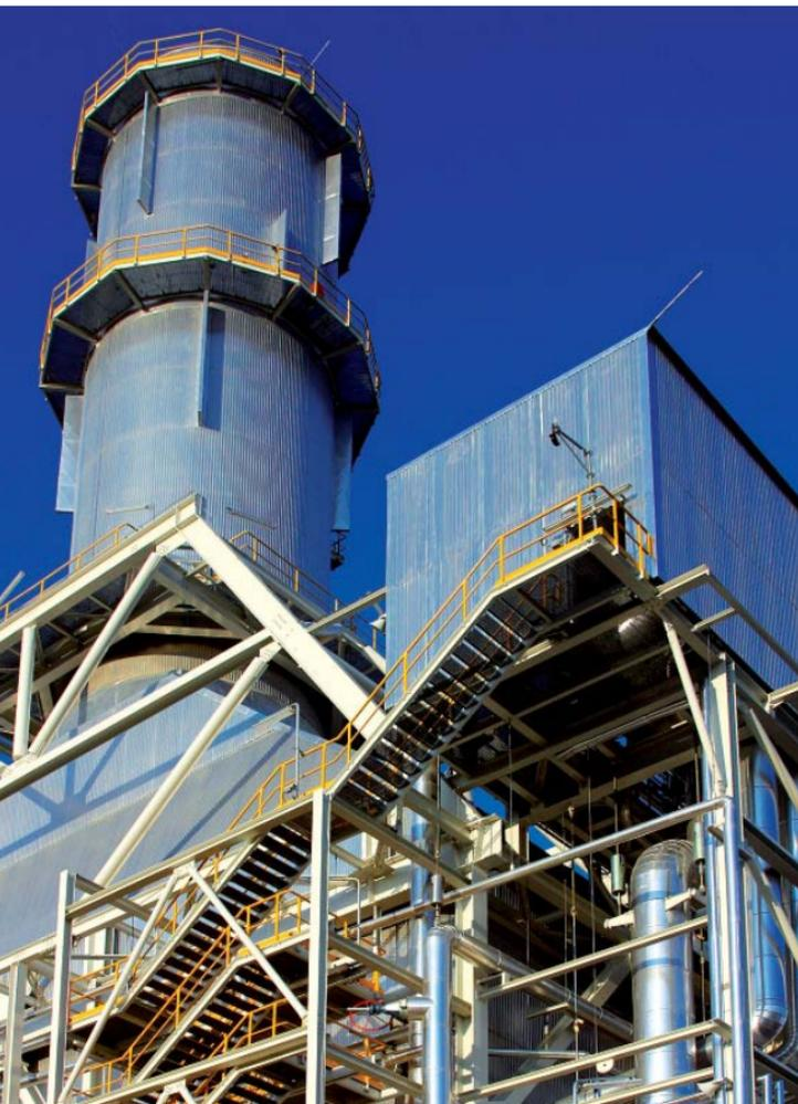
El control de las emisiones de la central se realiza mediante equipos de medición en continuo instalados en la chimenea, que proporcionan un registro continuo de los niveles de emisión de contaminantes y el control de los parámetros de la combustión que condicionan dichos niveles.
