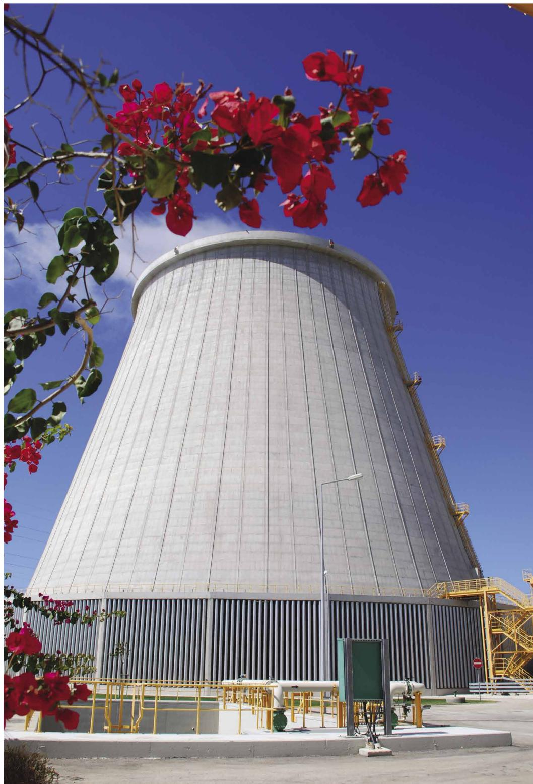
O circuito de água de arrefecimento é do tipo fechado, com torre evaporativa e ventilação assistida. Existem duas torres com 60 metros de altura: uma comum aos Grupos 1 e 2, e a outra, de menor diâmetro, exclusiva do Grupo 3.
